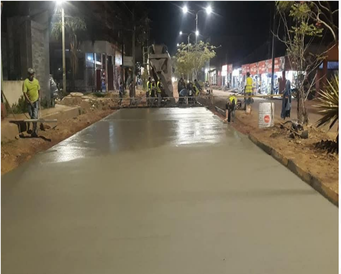
Figura 2 CALLES CON PAVIMENTO RIGIDO
